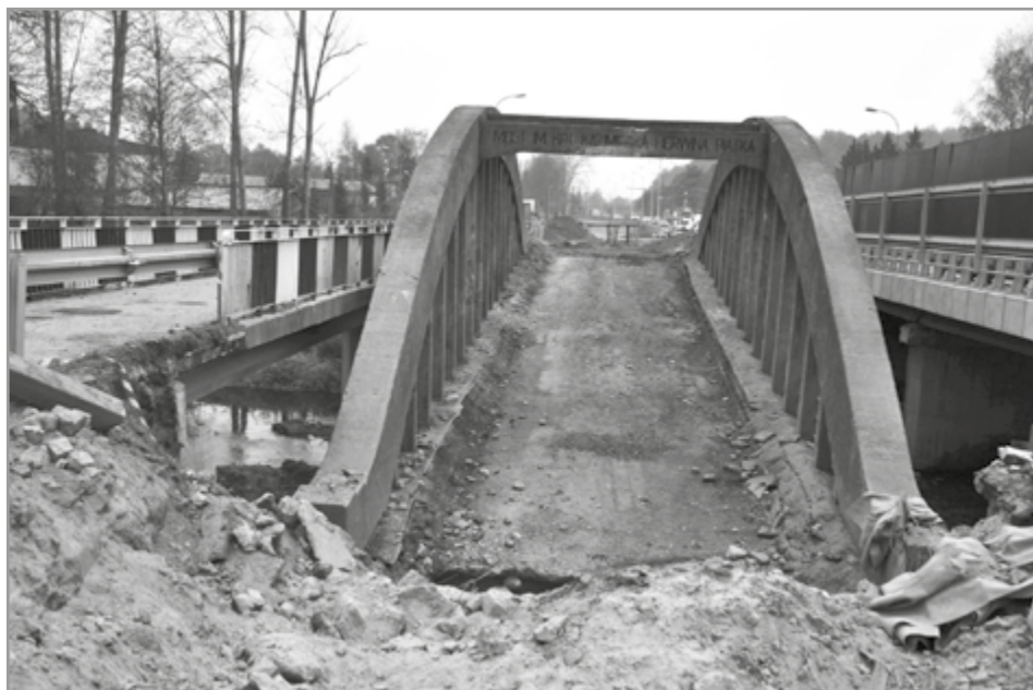
6. Prześło po wysadzeniu przyczółka mostu, 21.11.2011 r.
