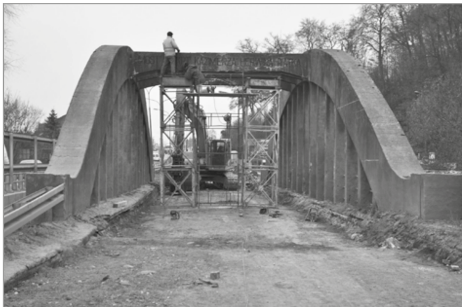
4. Przygotowanie do wycinania tężnika, 15.11.2011 r.
