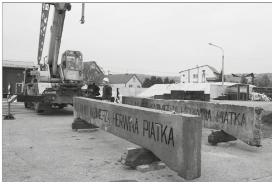
9. Skrajne tężniki mostu przechowywane w bazie Rejonu Dróg Wojewódzkich, oddział w Zgórsku, przygotowane do renowacji, 24.10.2016 r..
