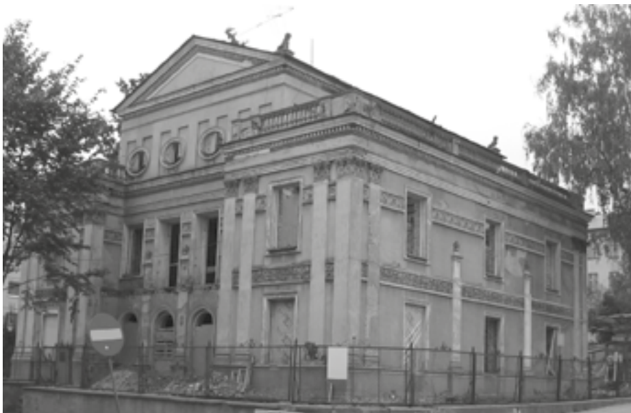
Dawna willa Hûetów, ul. Słowackiego 25, w trakcie remontu w 2011 r.
