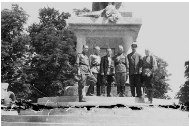
Il. 3. Rosyjscy budowniczowie pomnika przed jego odsłonięciem, lipiec 1945 r.
